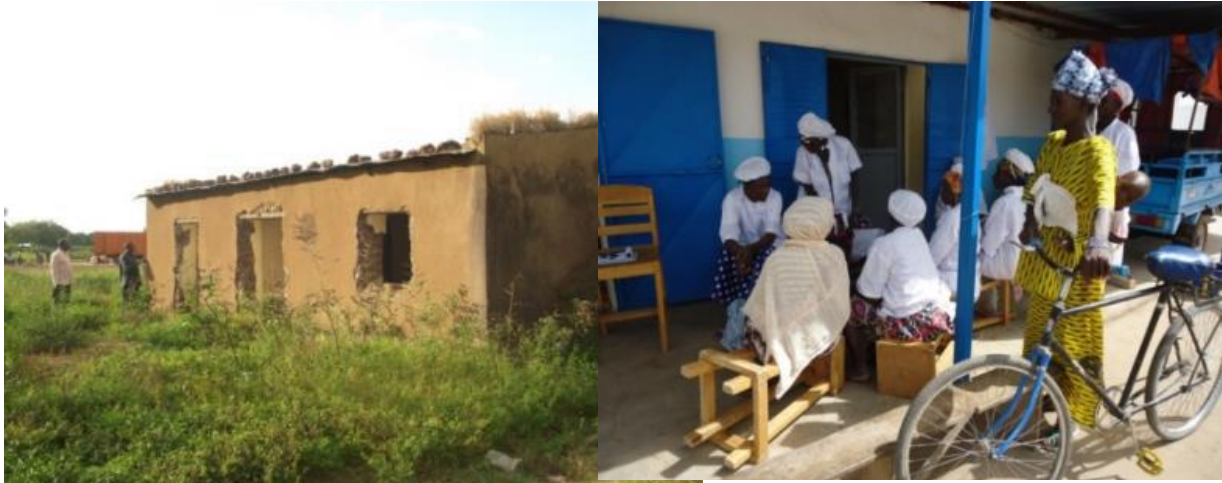
Figure 1 : UTC de N'Tobougou avant (à gauche) et après (à droite) la réhabilitation
